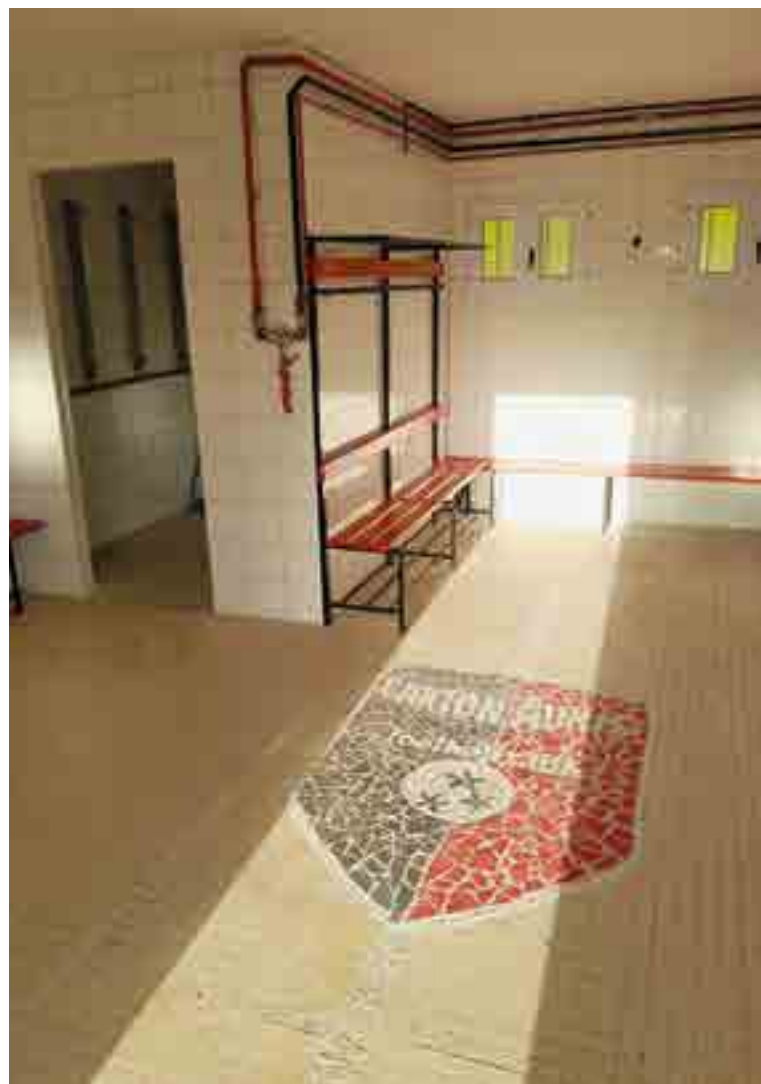
La fin de rénovation des vestiaires (2 e et dernière tranche)
