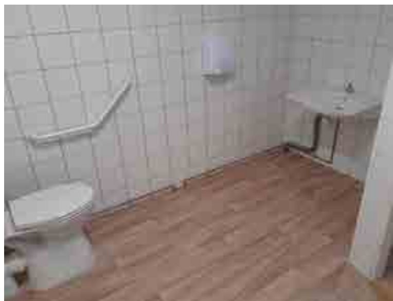
L'aménagement de WC PMR à la salle des Aînés et au stade municipal
