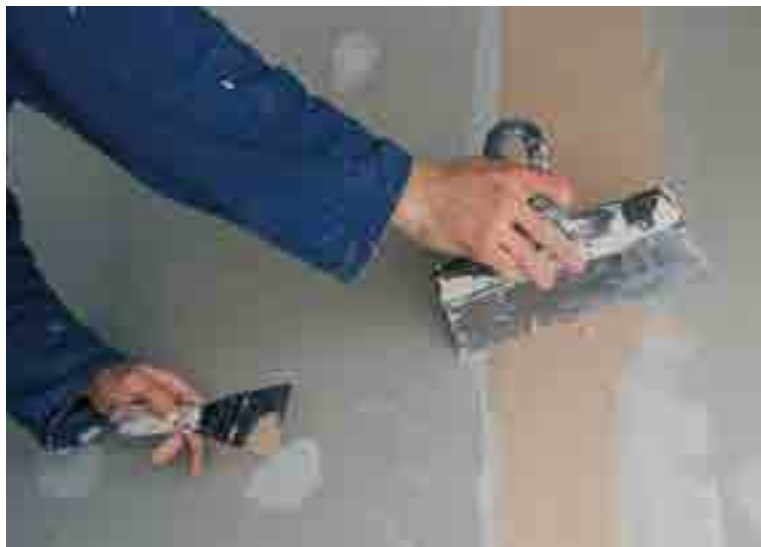
La rénovation des logements 101 rue des Distilleries et 165 rue Léopold et Jules Bayle
