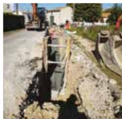
Le diagnostic du réseau d'assainissement avait été réalisé précédemment. Cela a conduit aux travaux 2022 rue de la Mare, du Fourneau, et autres rues de La Barlerie-Poléon afin de réparer les canalisations sujettes aux infiltrations d'eaux claires parasites.
