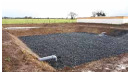
Lit d'infiltration en cours de réalisation.
